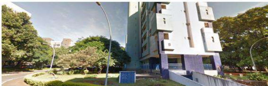
Imagem lateral do prédio
